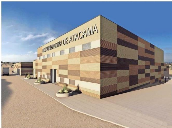
Hoy se construye en la Región de Atacama la planta desalinizadora más grande del país (Econssa).
