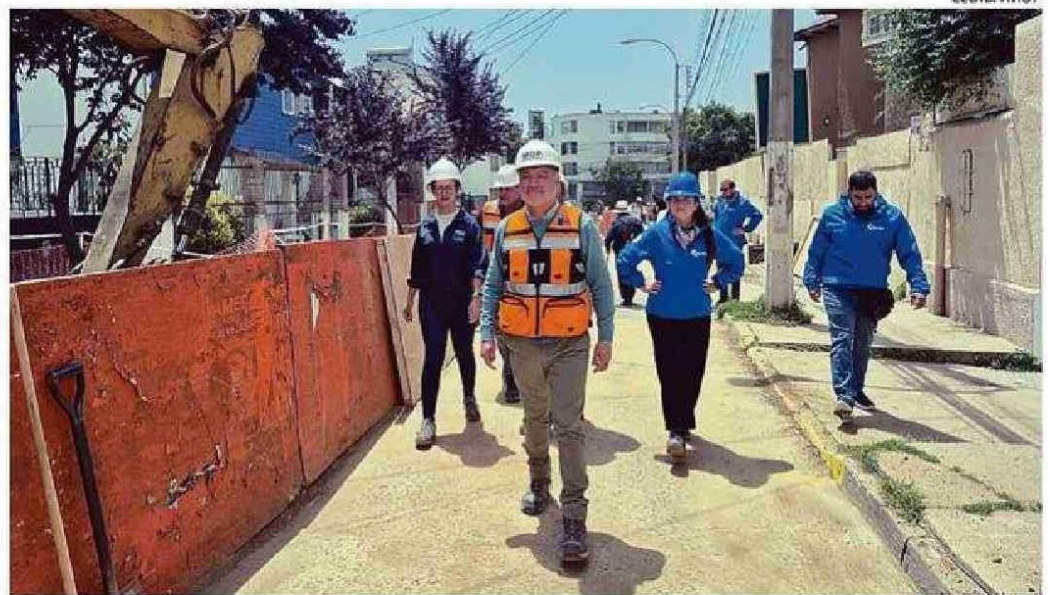
LAS AUTORIDADES INSPECCIONARON AYER EL COLECTOR UBICADO EN CALLE NUEVE DE RECREO.
