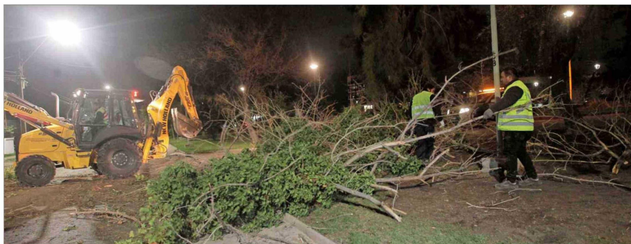
Desde el Gobierno se abrieron a la posibilidad de que los fondos reunidos por multas que está sancionando la SEC sean destinados al proyecto de subsidios eléctricos.
