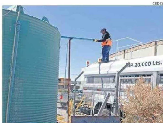
CON UN CAMIÓN ALJIBE Y ESTANQUES DE ALMACENAMIENTO TRABAJAN.
