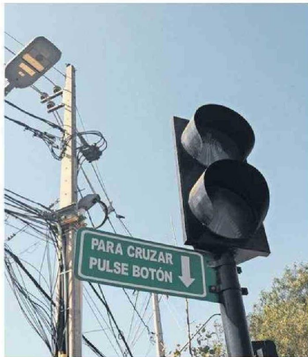
SEMAFOROS APAGADOS GENERARON PROBLEMAS EN EL TRÁNSITO.
