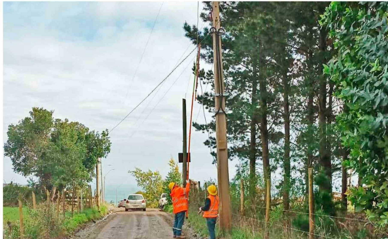
Las punteras con motobombas, con las cuales se abastecen de agua potable para consumo humano, no pueden funcionar.
