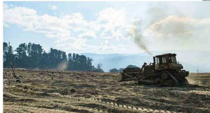
EL VERTEDERO DE MORROMPULLI RECIBE RESIDUOS DE LAS DOCE COMUNAS DE LA REGIÓN.
