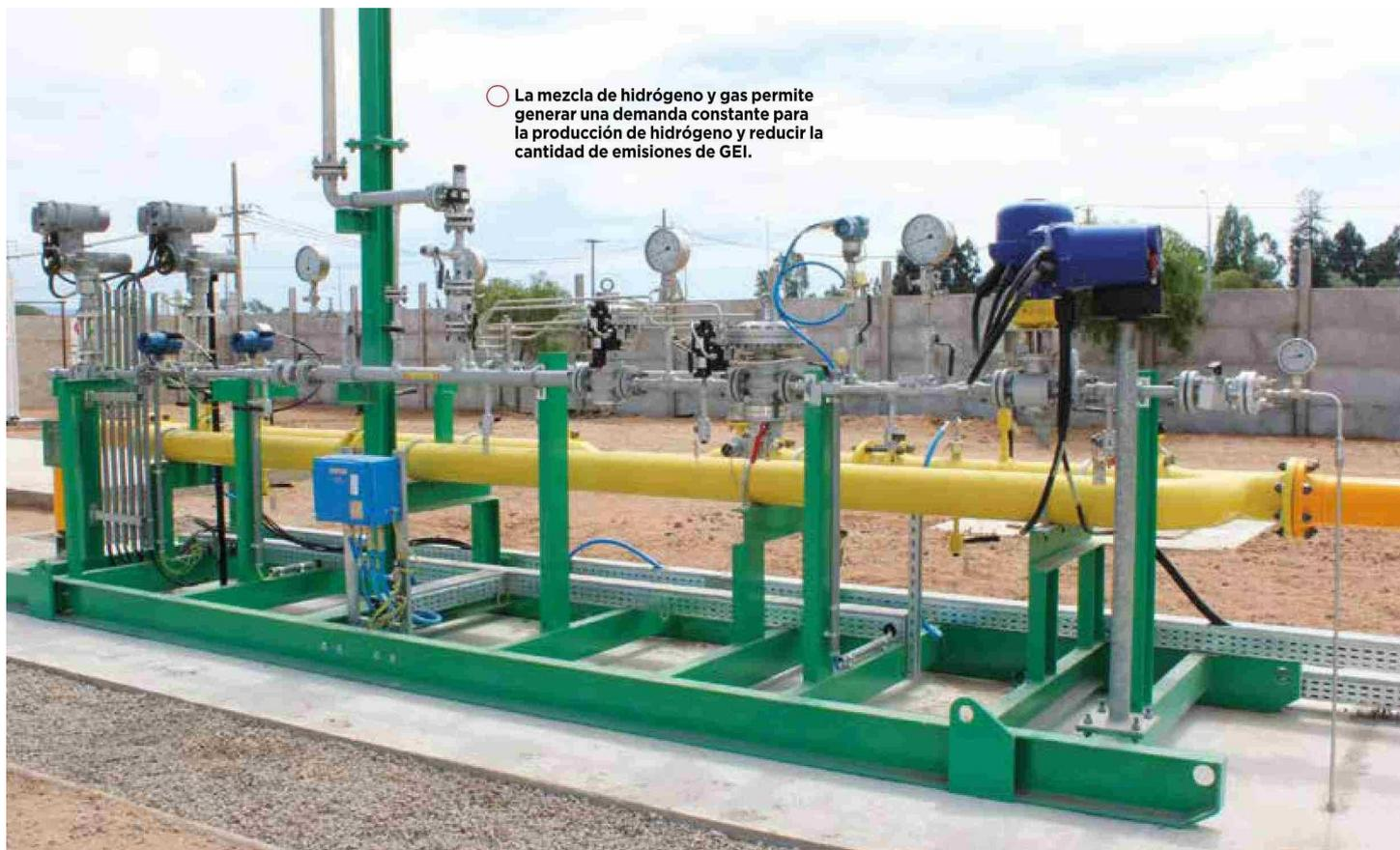
○ La mezcla de hidrógeno y gas permite generar una demanda constante para la producción de hidrógeno y reducir la cantidad de emisiones de GEI.
