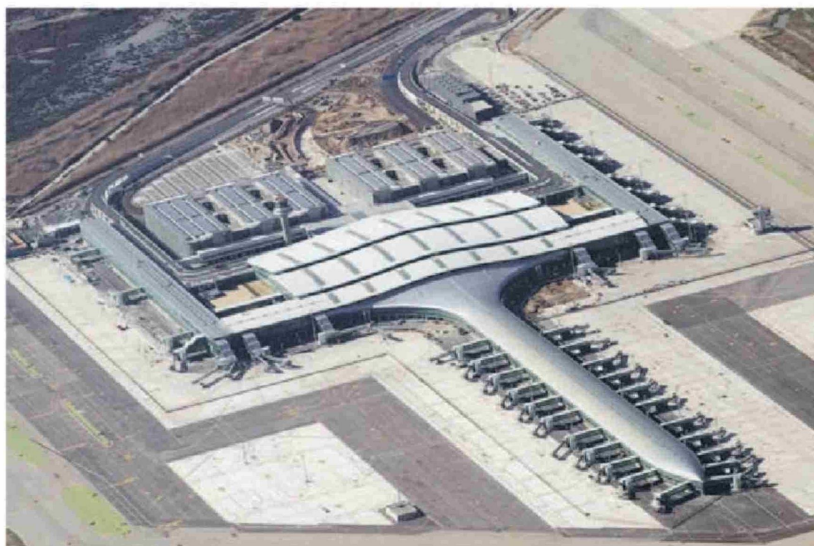
En la ampliación del Aeropuerto de Palma de Mallorca, ACCIONA utilizó un tipo de acero compuesto en un 93% de materiales reciclados, lo que evitó la generación de 1.900 tons. de emisiones de CO 2 . Foto: ACCIONA.
