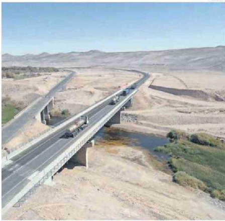
SE HIZO EL CIERRE DE OBRAS DE REPOSICIÓN DEL PUENTE.
