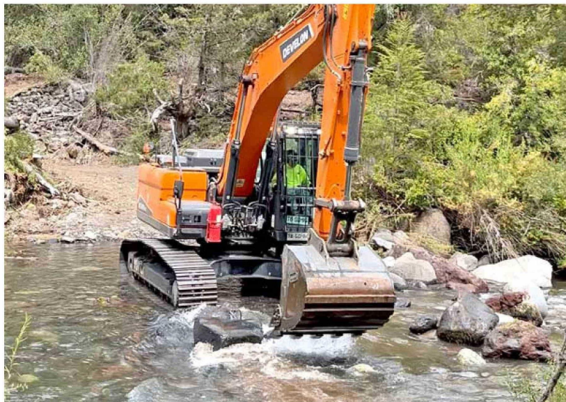
Con maquinaria pesada se logró realizar vados que permitirá atravesar el río y poder agilizar el paso vehicular.
