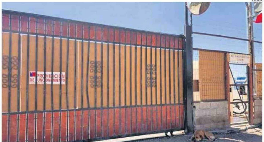
POR UNA SERIE DE FALENCIAS SANITARIAS COMO TAMBIÉN DE SEGURIDAD CLAUSURAN “GRAN HOTEL” EN AVENIDA BALMACEDA DE CALAMA.
