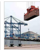
Durante la cumbre de APEC inauguraron el megapuerto de Chancay, construido con capitales chinos y con el que Perú intenta ser el principal centro logístico de la región. | B 6
