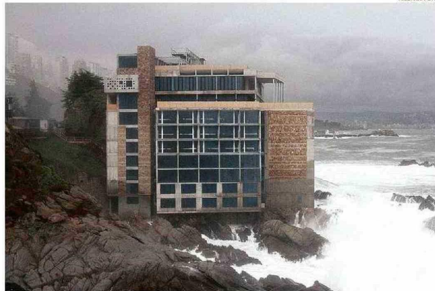
HAY ORDEN DE DEMOLICIÓN CONTRA EL HOTEL DICTADA POR SEREMI DE VIVIENDA DE VALPARAÍSO.
