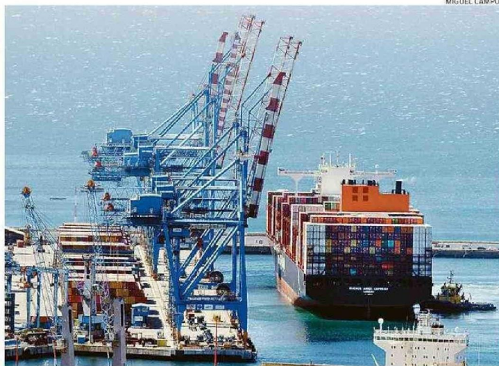
PUERTOS DE VALPARAÍSO Y SAN ANTONIO TRABAJAN EN LA AMPLIACIÓN DE SU CAPACIDAD DE CARGA.
