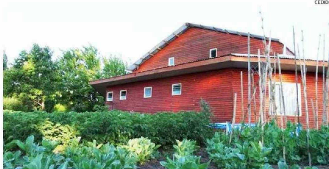
LA RESIDENCIA CUENTA CON ESPACIOS COMUNITARIOS. SE UBICA EN EL SECTOR DE MAILE, A 40 KM. DE OSORNO.
