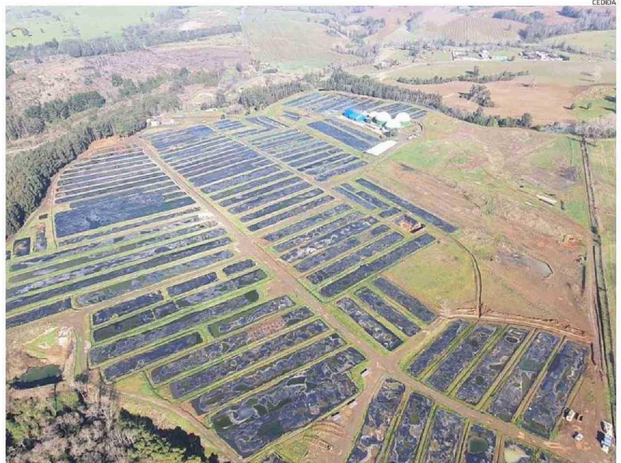
EL TERRENO DONDE ESTÁ LA PLANTA ECOPRIAL ES DE CASI 57 HECTÁREAS, DE LAS CUALES ESTÁN OPERATIVAS POCO MENOS DE LA MITAD.
