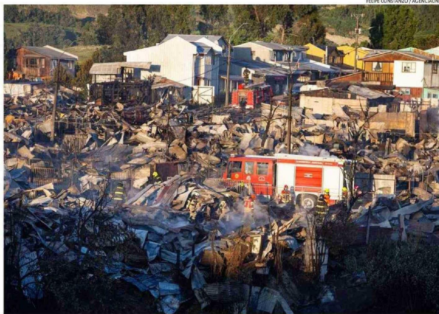
EL SINIESTRO DEJÓ UN ESCENARIO DE TOTAL DESTRUCCIÓN EN EL SECTOR ALTO DE CASTRO, DONDE SE DESPLEGARON 35 CARROS BOMBA.
