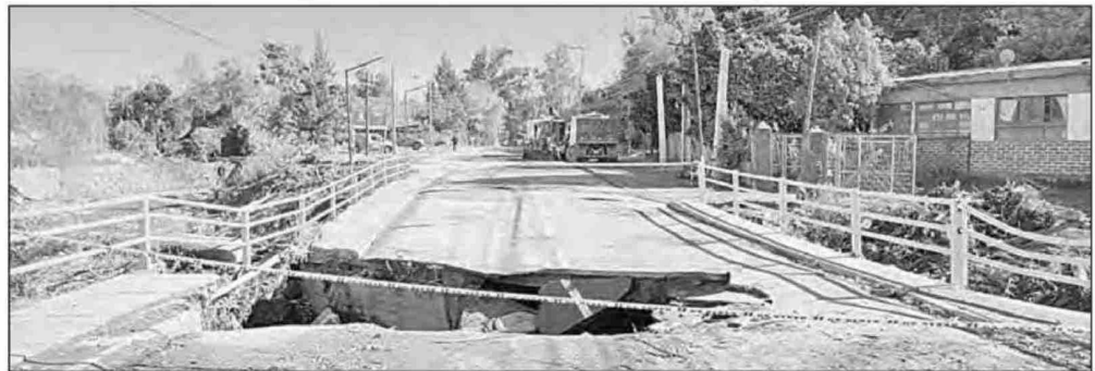
Tras el desborde del estero Los Loros el puente Merino quedó inutilizable, por lo que se gestionó un puente mecano.
