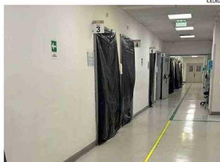
COMENZARON LOS TRABAJOS EN LOS BOX DE ATENCIÓN.
