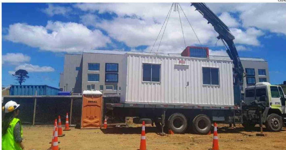
LAS ACTUALES LABORES DE SURALIS INCLUYEN LA CONSTRUCCIÓN DE ZANJAS UTILIZANDO MAQUINARIA PESADA.
