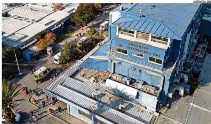
EL SÓTERO DEL RÍO, UBICADO EN PUENTE ALTO, ES UNO DE LOS PRINCIPALES HOSPITALES DE LA CAPITAL.
