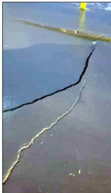
Con graves daños en su estructura resultó el puente Merino, cuya calzada se fracturó y quedó totalmente inutilizable.
