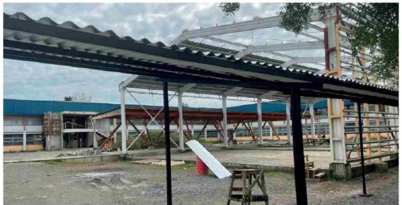
EL MUNICIPIO TAMBIÉN está abordando el retiro de escombros y otros materiales dejados por la empresa constructora, mientras se prepara para la próxima fase del proyecto.
