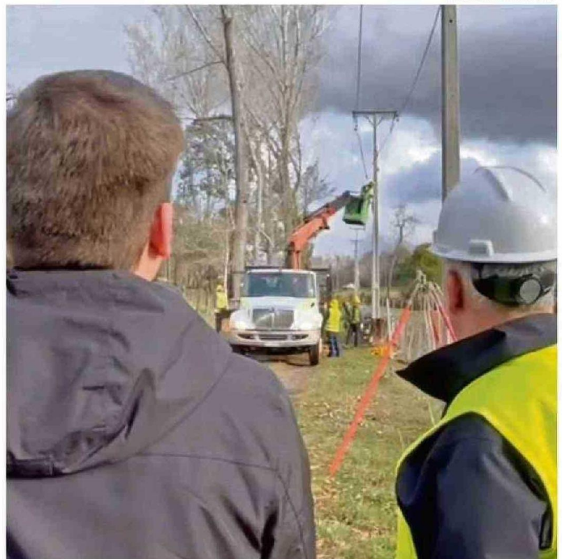
LA RECONSTRUCCIÓN DEBIERA APUNTAR A UNA INFRAESTRUCTURA RESILIENTE, OPINA EL SEREMI DE ENERGÍA.
