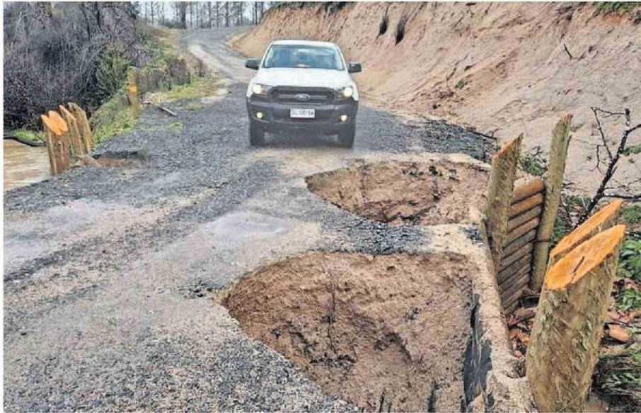
Trabajo en rutas y reposición de suministro eléctrico ha sido la prioridad tras el paso del intenso sistema frontal en la región del Biobío.
