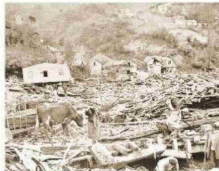
Registro captado por el Piloto Pardo de la destrucción del terremoto de 1960.
