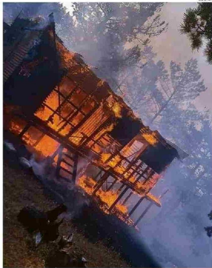
ASÍ QUEDÓ LA VIVIENDA TRAS LAS LLAMAS. EN LA EMERGENCIA NO HUBO HERIDOS.
