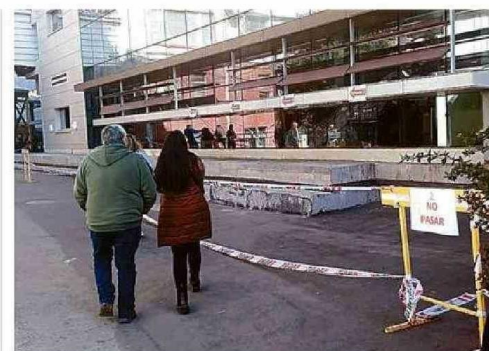
SE INSTALÓ UN CIERRE PERIMETRAL POR CALLE ÁLVAREZ.
