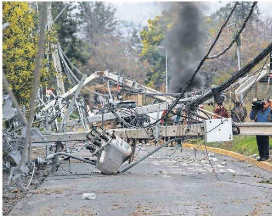
Infraestructura eléctrica fue dañada por vientos de más de 120 km/h en la capital a inicios de mes.
