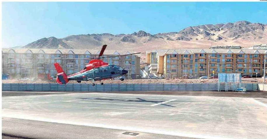
ESTE AÑO, EL MOP INAUGURÓ EL PUNTO DE POSADA PARA HELICÓPTEROS CENTELANTO, EN EL CENTRO DE TELECOMUNICACIONES DE LA ARMADA.
