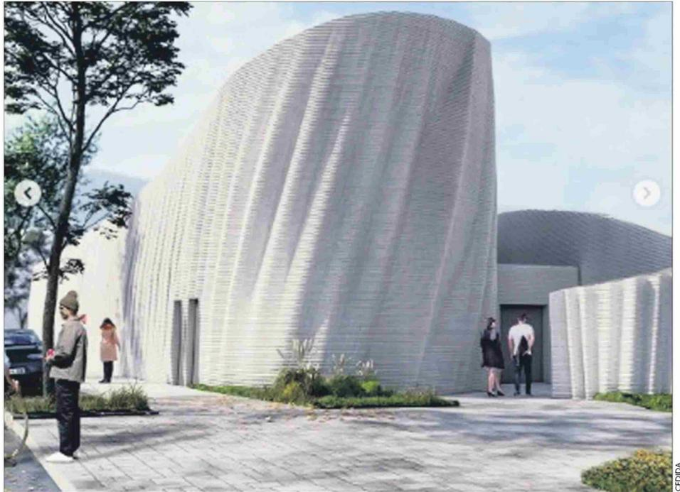
La construcción de 600 mt2 está en Alemania donde imprimen 4 mt2 de edificio por hora
