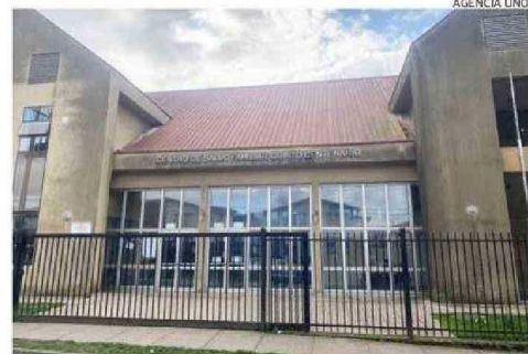
EL CESFAM HA QUEDADO SIN LUZ DURANTE FINES DE SEMANA COMPLETOS.
