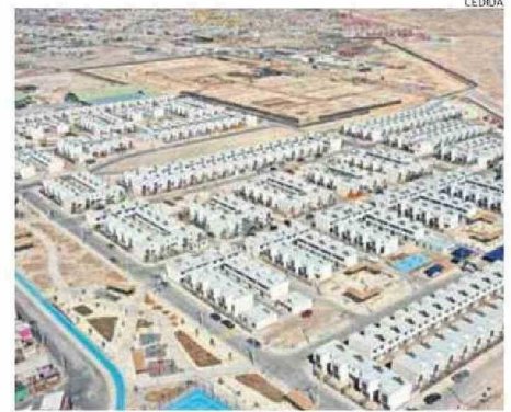
CONCLUYÓ ENTREGA DE 439 VIVIENDAS DE PROYECTO RENÉ SCHNEIDER.
