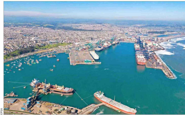
Las primeras obras considerarán la construcción de un molo de unos cuatro kilómetros de extensión y el dragado en el área de la futura dársena.
