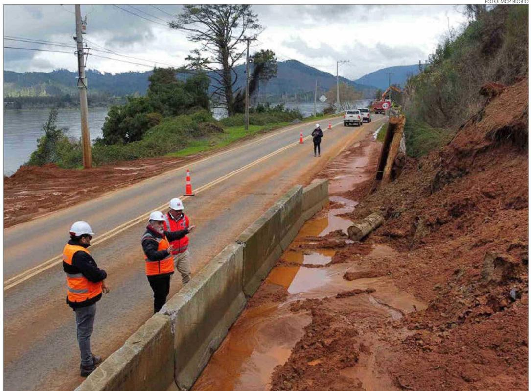
**MUROS DE CONTENCIÓN** Instalados en los últimos meses probaron ser efectivos en contener parte de los deslizamientos en la Ruta.
