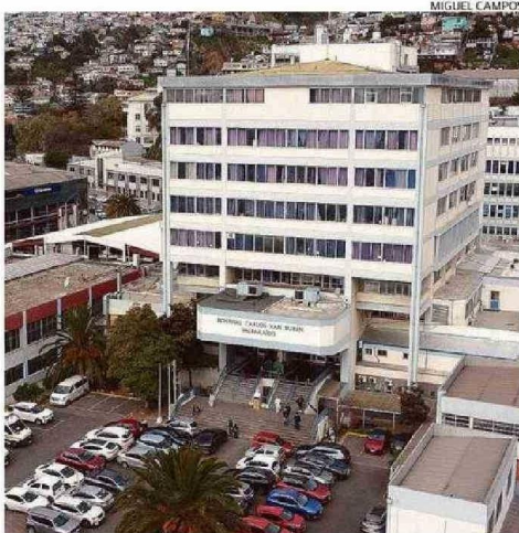
EL PRESUPUESTO DEL HOSPITAL VAN BUREN ESTÁ EN ESTADO CRÍTICO.
