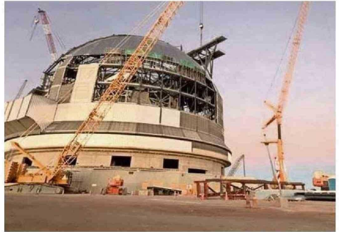
LA CÚPULA QUE ALBERGARÁ AL EXTREMELY LARGE TELESCOPY EN 2028 ESTÁ EN FASE DE CONSTRUCCIÓN.
