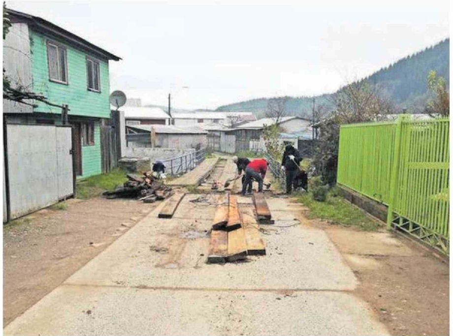
En la comuna de Curanilahue hay diversas infraestructuras de uso peatonal y vehicular que aún no cuentan con obras de reparación.
