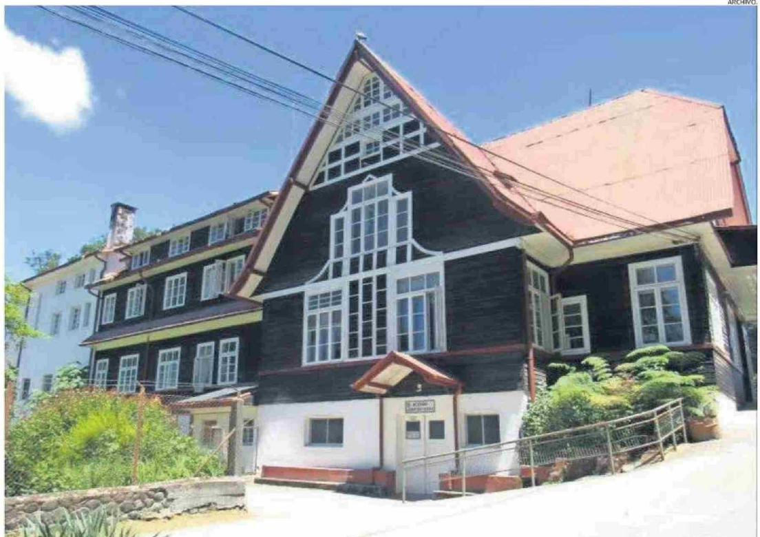
EL HOSPITAL DE PANGUIPULLI ES ADMINISTRADO POR LA CONGREGACIÓN HERMANAS DE LA SANTA CRUZ, A TRAVÉS DE LA FUNDACIÓN HOSPITAL DE PANGUIPULLI.
