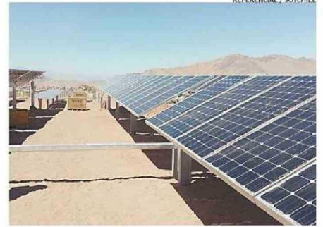
OBRAS BUSCAN PARTIR EN 2026.
