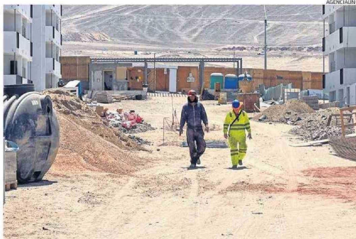
LOS PROYECTOS ALTO PARINACOTA, ALTO DEL SOL Y LICANCABUR ESTÁN A CARGO DE LA CONSTRUCTORA PACAL.
