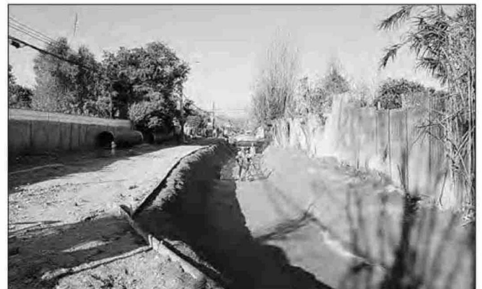
El puente en cuestión se ubica en la intersección de las calles Lima y Condell.
