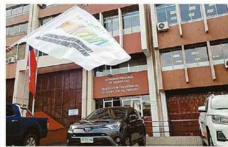
EL EDIFICIO ESMERALDA DEBE SER SOMETIDO A REFACCIONES.
