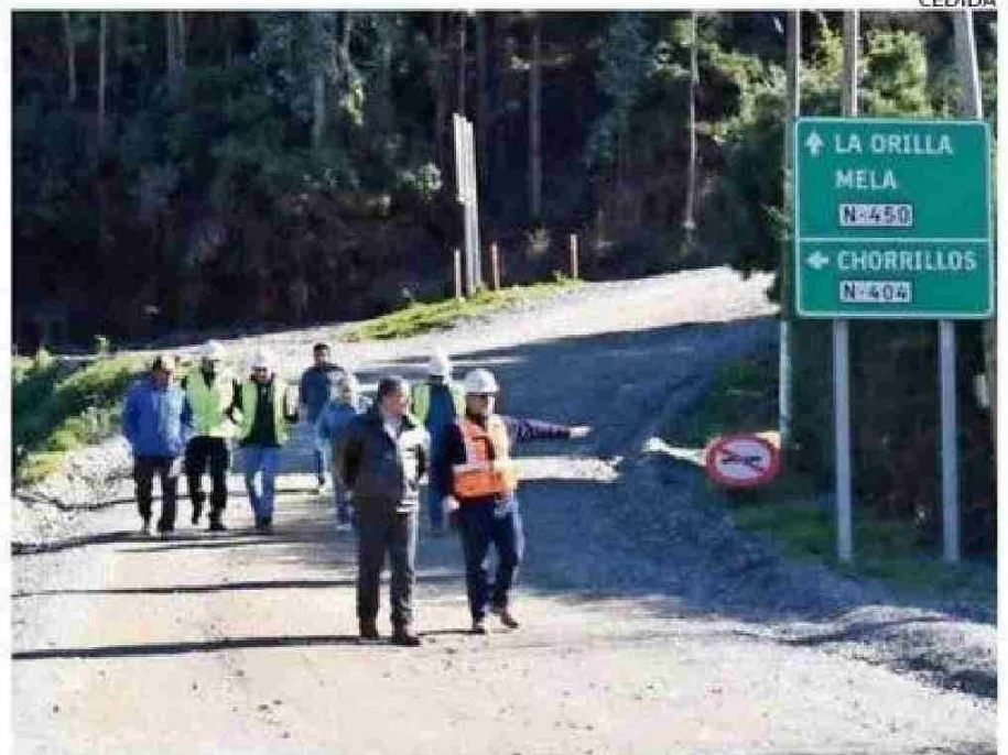
SE TRATA DE ASFALTADO EN LA RUTA N-42.
