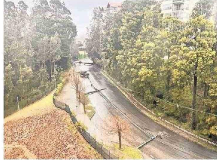
En el sector de Andalué, comuna de San Pedro de la Paz, el viento causó la caída de postes del tendido eléctrico.
