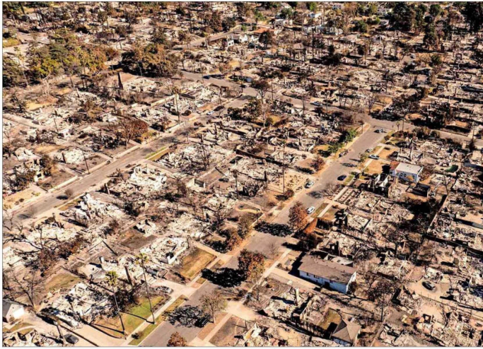
Una vista aérea de las casas quemadas en el incendio de Los Angeles.
