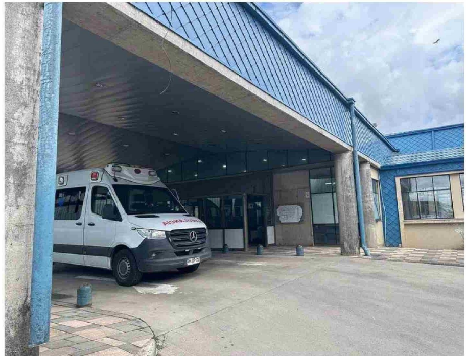
UNA MAYOR INFRAESTRUCTURA REQUIERE EL HOSPITAL DE CASTRO PARA TERMINAR CON EL COLAPSO DENUNCIADO POR DIRIGENTE.
