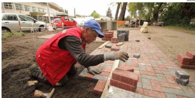
EL MEJORAMIENTO DE LA AVENIDA GABRIELA MISTRAL TIENE UNA EXTENSIÓN MÁS DE DOS KILÓMETROS.
