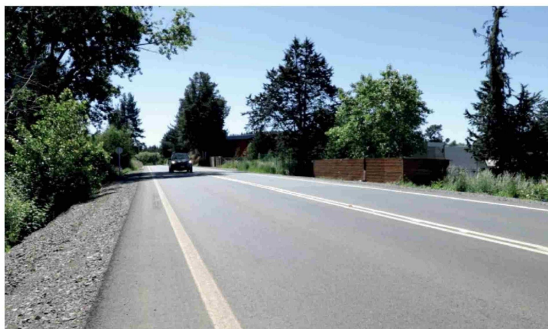
HACE POCO MÁS DE DOS AÑOS se iniciaron los trabajos de pavimentación de la Ruta Q-80, que une las comunas de Mulchén-Negrete. (cedidas).
